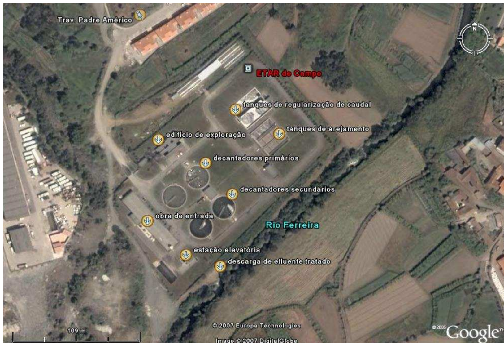
Figura 4 – Vista aérea da ETAR de Campo. Localização dos principais órgãos de tratamento e edifícios de apoio. (Google Earth, Janeiro 2007).
